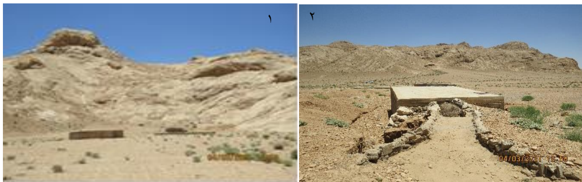
شکل ۲- احداث آب‌انبار در مناطق قشلاقی عرب جرقویه اصفهان؛ ۱. نمایی از کوه‌های لخت با سطح صیقلی و آب‌انبار؛ ۲. محل ورودی آب از سطح صیقلی به آب‌انبار
