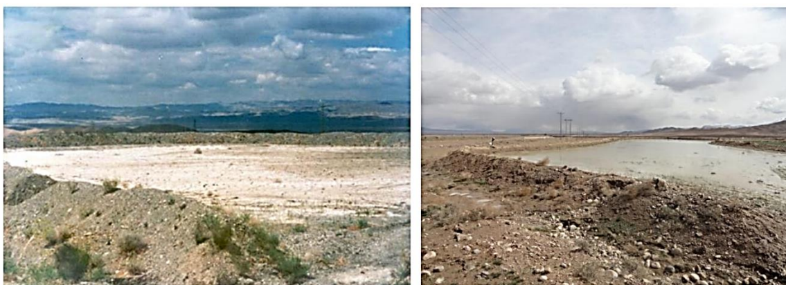
شکل ۶- نمای یک بندسار در زمان آبیگری (راست) و بعد از نفوذ آب به داخل زمین و رسوبگذاری (چپ)
