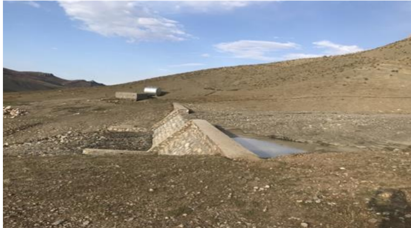
شکل ۳- آب ذخیره شده در پشت بند سنگی- ملاتی در ریز سر و تانکر ذخیره آب
